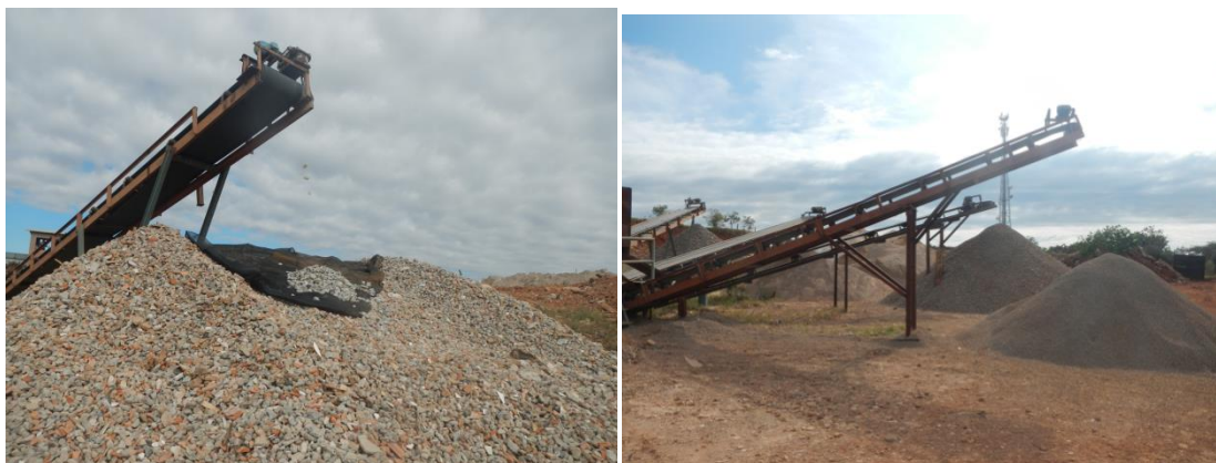
Figura 4: Processo de britagem do RPC com britador-de-mandíbulas e utilização de esteiras para classificação do tamanho dos agregados.
